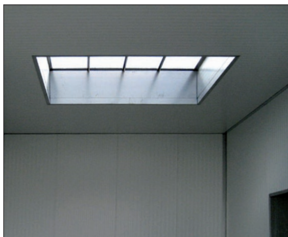
Lichtfeld im Dach
