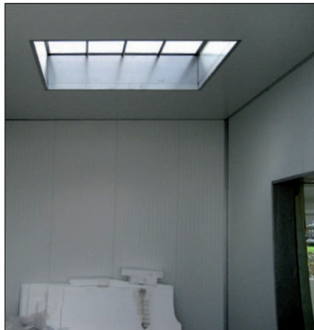
Isolierung am 2. Tag
