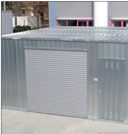
Fertigstellung der Halle: 16.00 h
